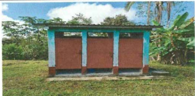
Foto 4: SUSTITUCION DE PUERTA DE SANITARIOS, POR DETERIORO DE LOS MISMOS
