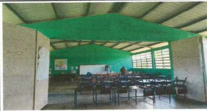
Foto 2: PINTURA EN MURO INTERIOR DEL ESTABLECIMIENTO
