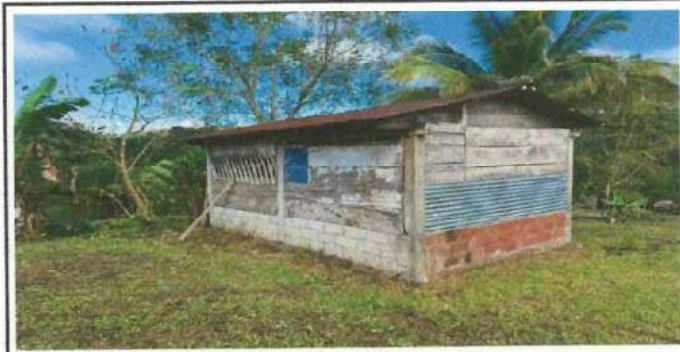
Foto 6: SUSTITUCION DE TABLAS POR BLOCK
