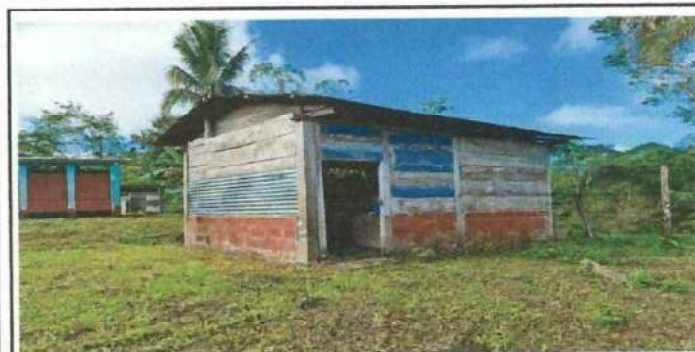
Foto 5: MEJORAMIENTO DE LA COCINA, CON BLOCK, ESTRUCTURA DE TECHO Y CUBIERTA DE LAMINA
