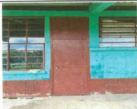
Foto 3: SUSTITUCION DE PUERTAS DEL ESTABLECIMIENTO POR DETERIORO DE LOS MISMOS
